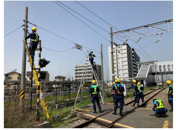
< 踏切パン線断線復旧訓練 >
