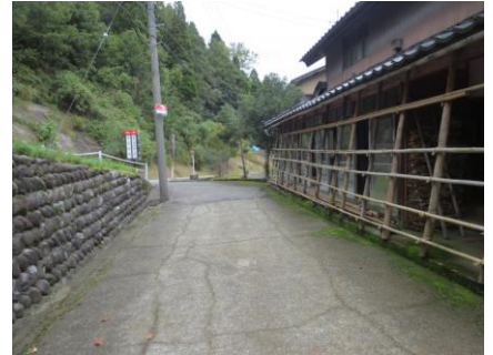
石川高専学生による改築予定の観光拠点(本多邸)
